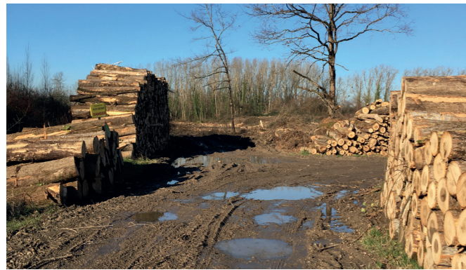
TRAVAUX SUR SITE DÉFRICHÉMENT - 30 DÉCEMBRE 2019 - SOURCE : VINCENT BES (CD82)
